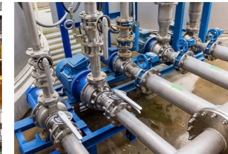
INDUSTRIELLER ROHRLEITUNGSBAU INDUSTRIAL PIPING
